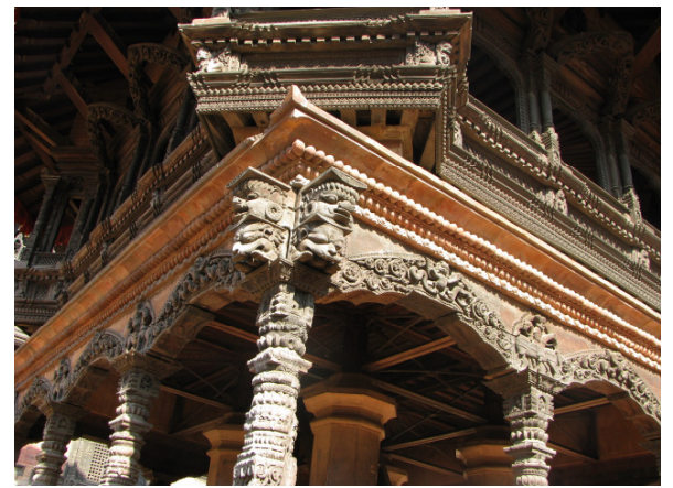
柱、窓、壁、屋根を支える方杖の見 事な彫刻
