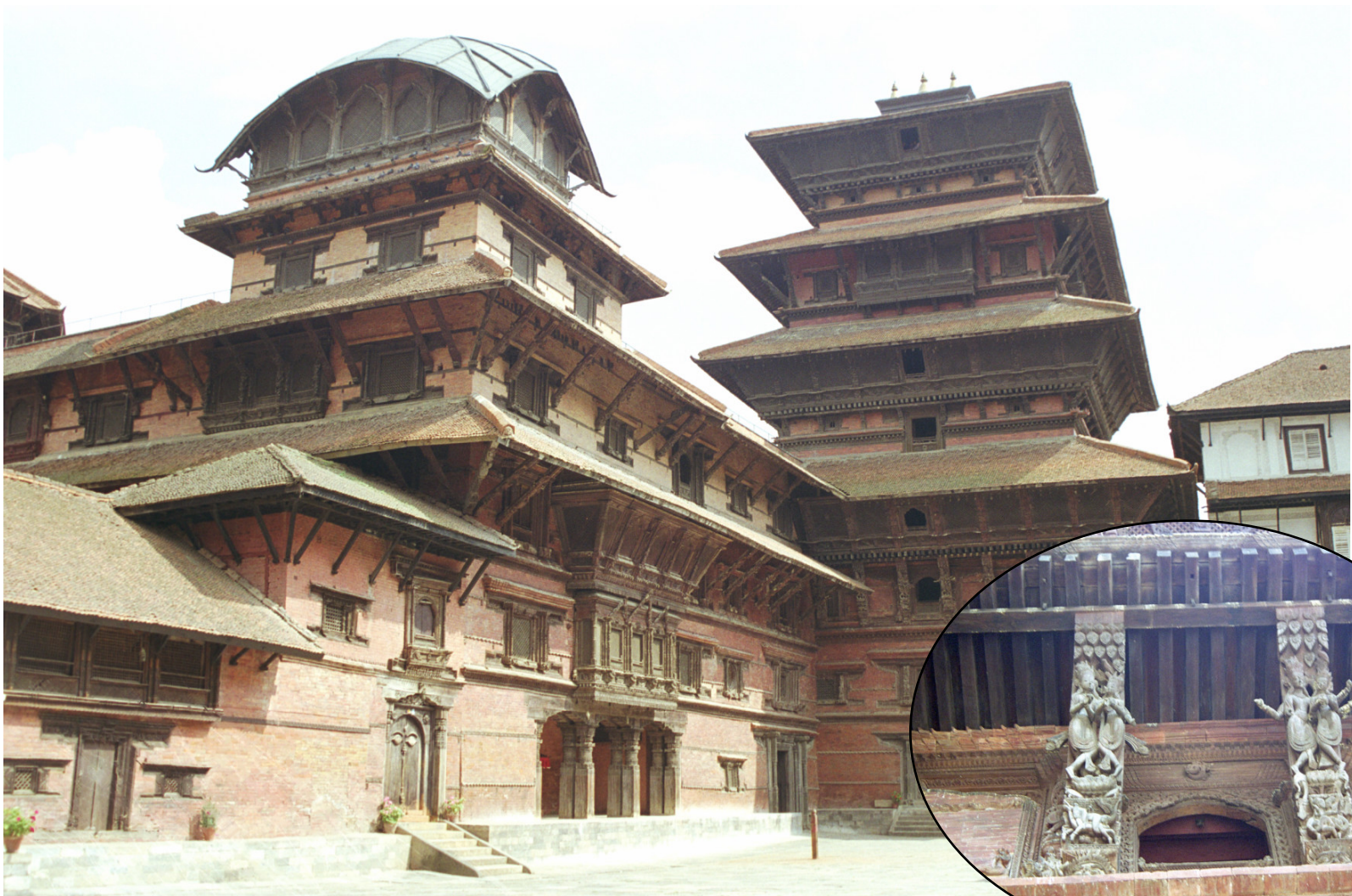
木造 9 階建、高さ 31m の旧王宮バサントプルバワン
