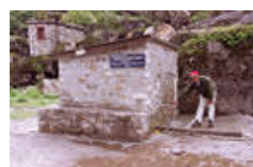
600m水道引込みと貯水槽
