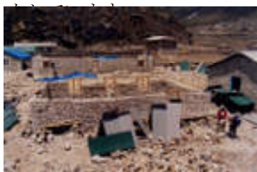
建設中の学生寮
