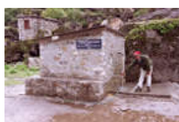
600m水道引込みと貯水槽
