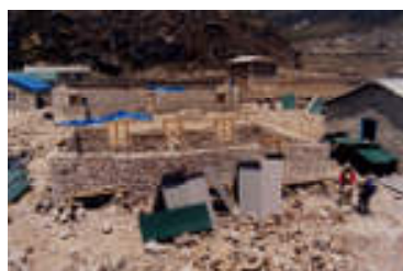
建設中の学生寮
